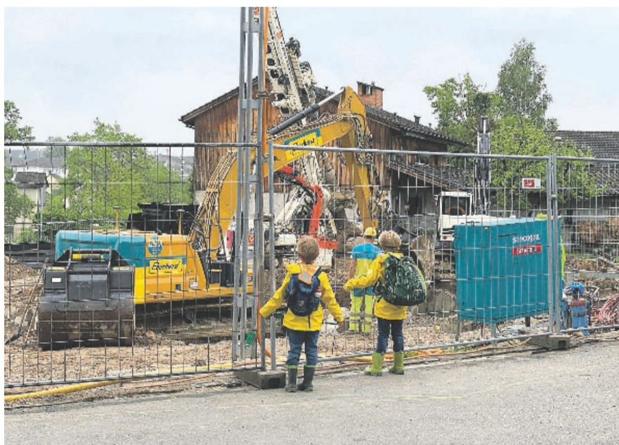
Es wird sehr viel gebaut in Kloten. Das stört aber diese beiden Jungs überhaupt nicht.
