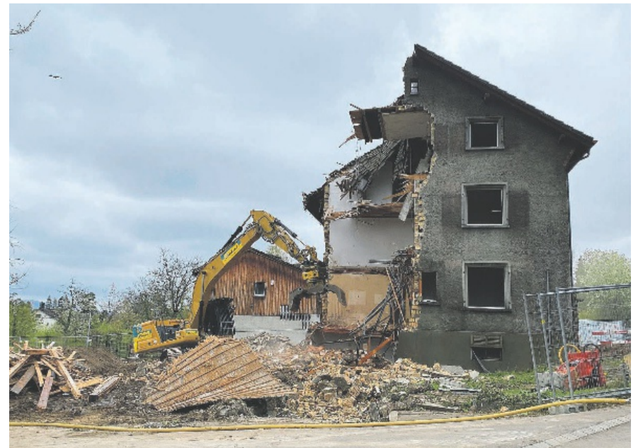
Der Abriss schreitet voran: Baustelle an der Holbergstrasse.
